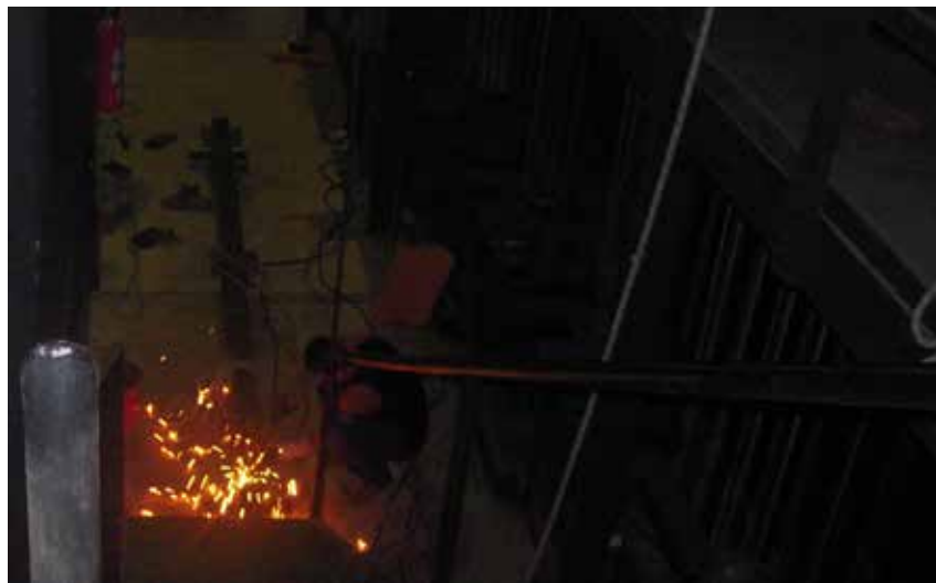
Obras não supervisionadas de reforma ou manutenção do edifício do museu utilizando chama exposta ou outras fontes de calor ou faíscas constituem um importante risco de incêndio (Foto: José Luiz Pedersoli Jr.).
