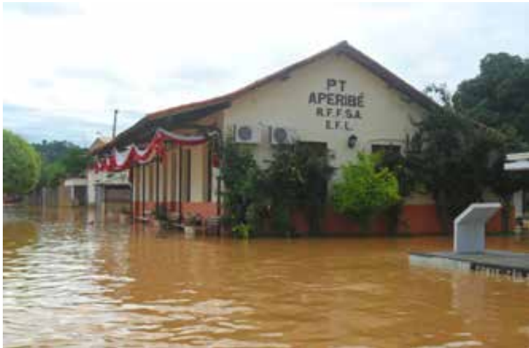
Exemplos de perigos para acervos museológicos nas diferentes camadas de envoltório. Inundação da área onde se localiza o museu devido à enchente de um rio próximo (sítio) (Foto: Instituto Brasileiro de Museus - Ibram).
