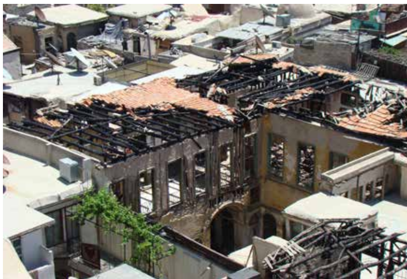
Edifício patrimonial danificado por incêndio (Foto: Firas Otman).
